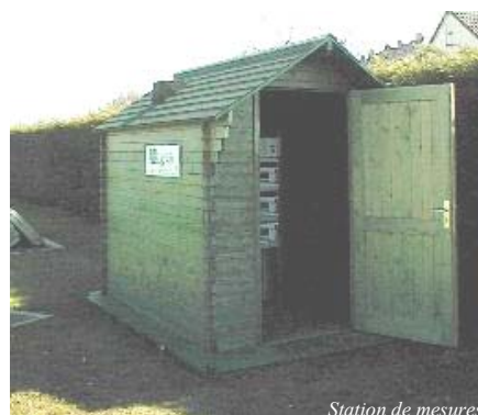
Station de mesures
