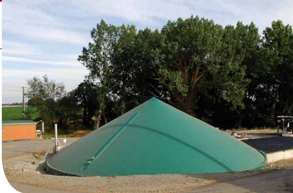
La couverture des fosses à lisier permet de réduire la volatilisation d'ammoniac.
